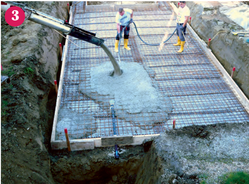
▲ Einbringung von Eisen und Beton in die abgeschallte Bodenplatte
