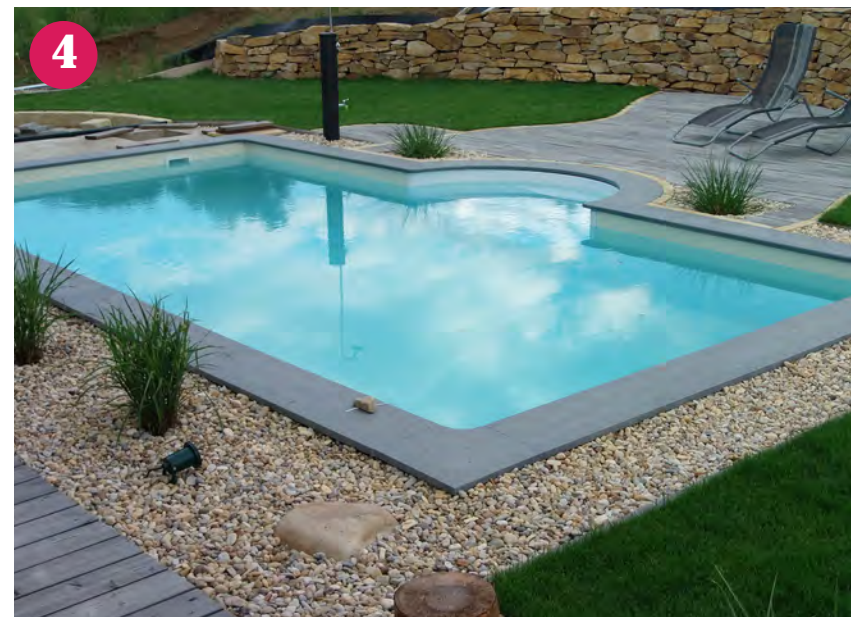
▲ Fertiges Styroporsteinbecken mit Römertreppe
