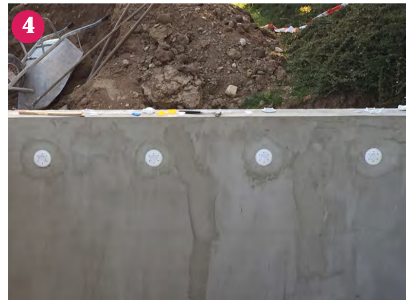
▲ Wichtig: Abdrücken der Rohrleitungen!
