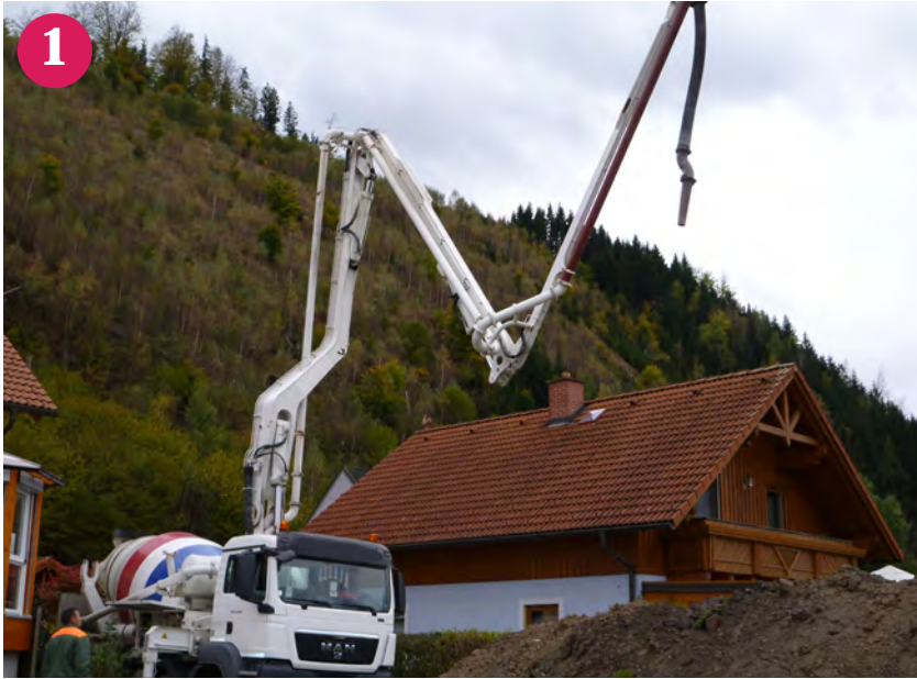
▲ Betonwagen mit Betonpumpe
