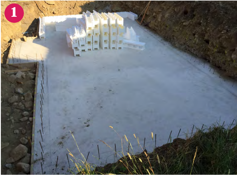
▲ Fertig ausgehärtete Bodenplatte
