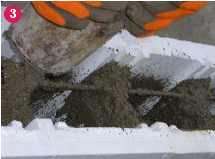
▲ Detailsicht: Ausfüllen der Styroporstein mit dem Beton
