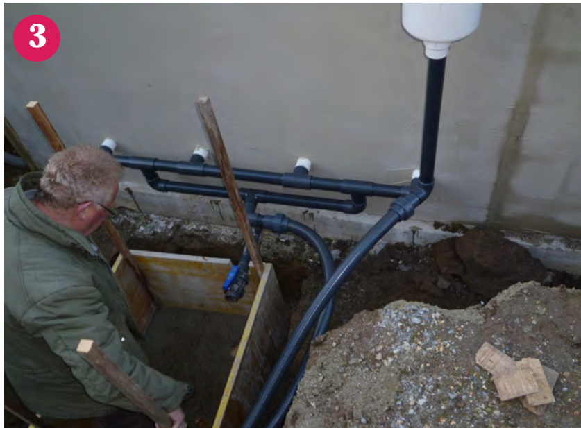
▲ Verrohrung von Düsen, Skimmer und Bodenablauf
