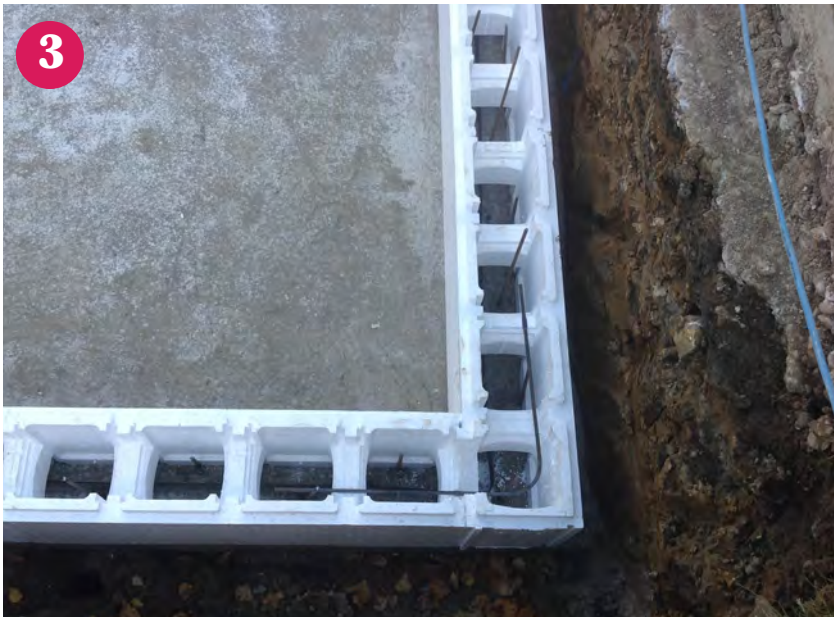
▲ Detailbild einer Eckverbindung samt Eisenarmierung
