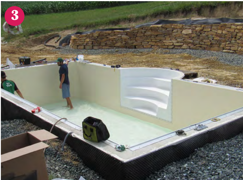
▲ Einhängen des Foliensacks und Anflanschen der Einbauteile
