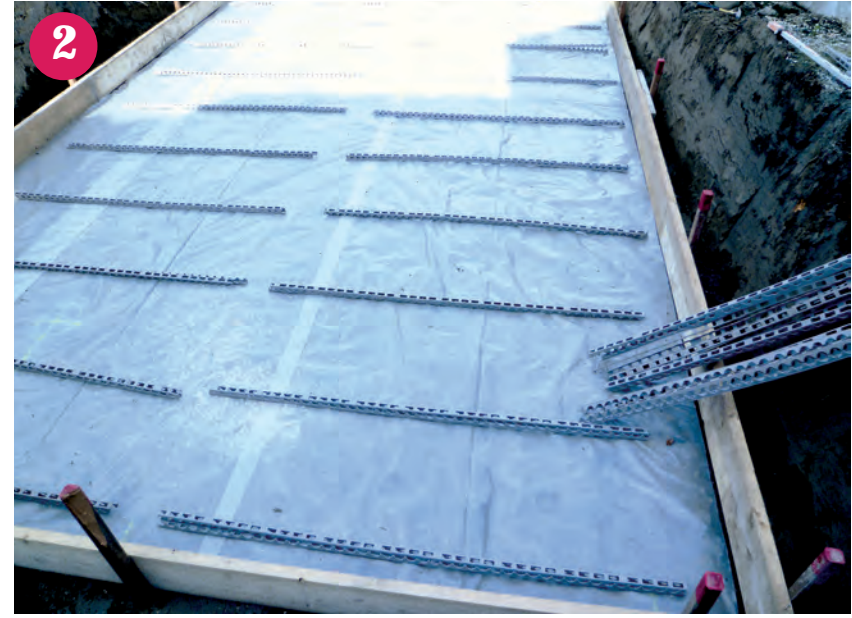
▲ Abschallung der Bodenplatte
