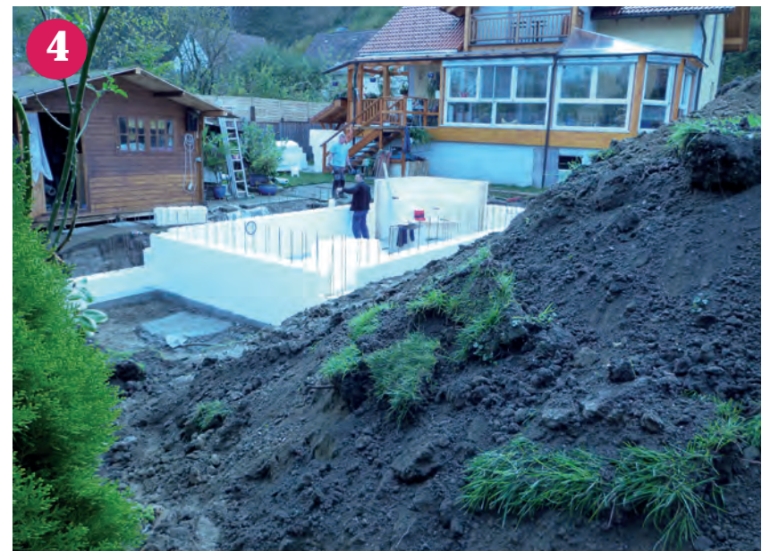
▲ Aufgestelltes Styroporstein Becken mit Ecktreppe – ohne Betonfüllung Ecktreppe
