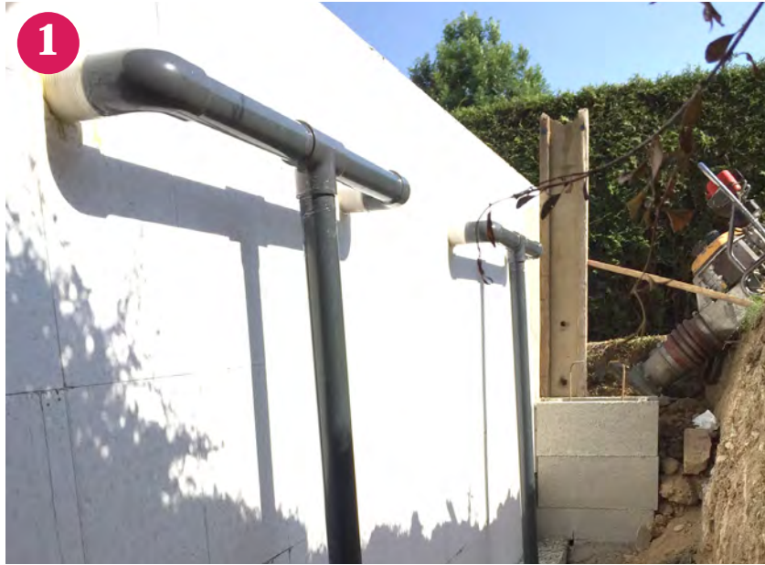
▲ Verrohrung von 4-Düsen
