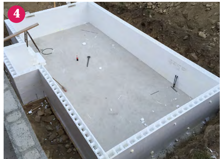
▲ Fertig aufgestelltes Styropor Becken – ohne Betonfüllung
