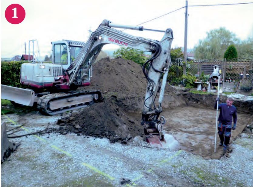
▲ Aushub der Baugrube
