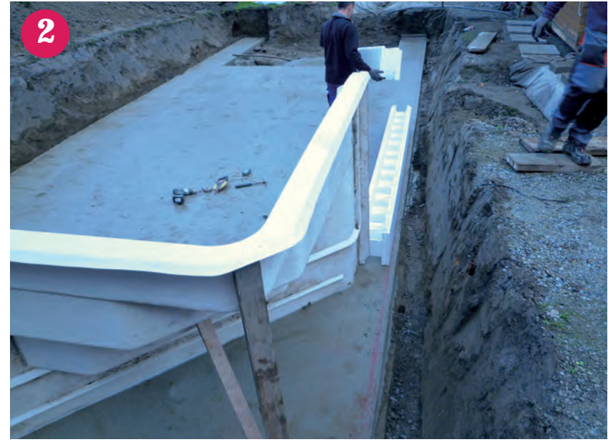
▲ Abstützen sowie senkrecht und waagerechte Einrichtung der Ecktreppe
