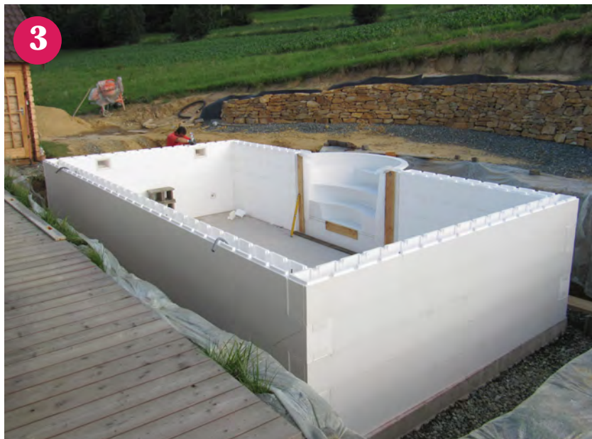
▲ Aufgestelltes Styroporstein Becken mit Römertreppe – ohne Betonfüllung
