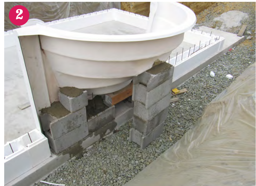
▲ Untermauerung der Römertreppe
