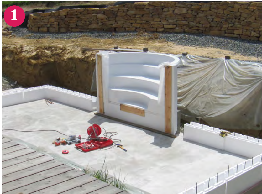
▲ Römertreppe mit erster Ansatzreihe Styroporsteine
