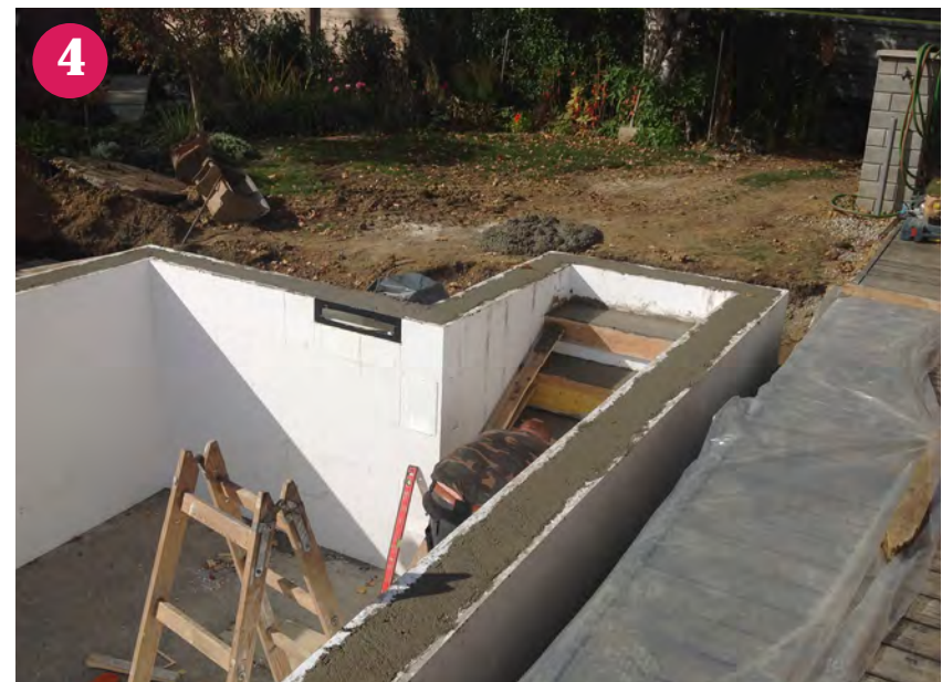
▲ Fertig ausgefülltes Styroporsteinbecken mit Beton
