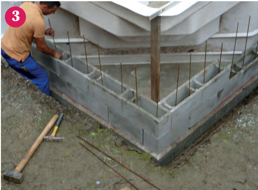
▲ Untermauerung der Ecktreppe
