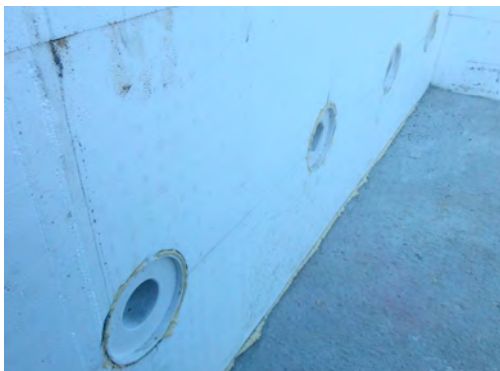
▲ Fertig eingeschäumte Wanddurchführung
