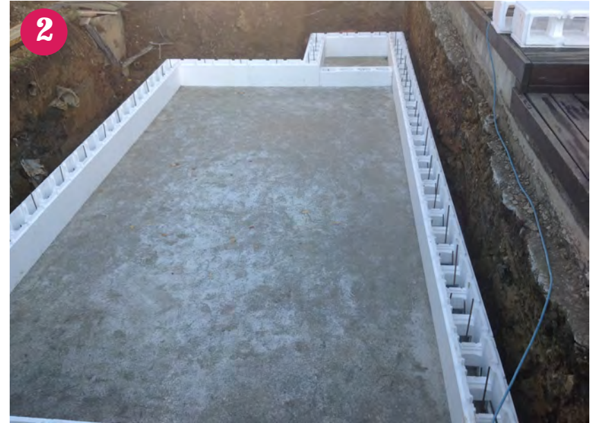
▲ Ansätzen der ersten Reihe Styropor Steine
