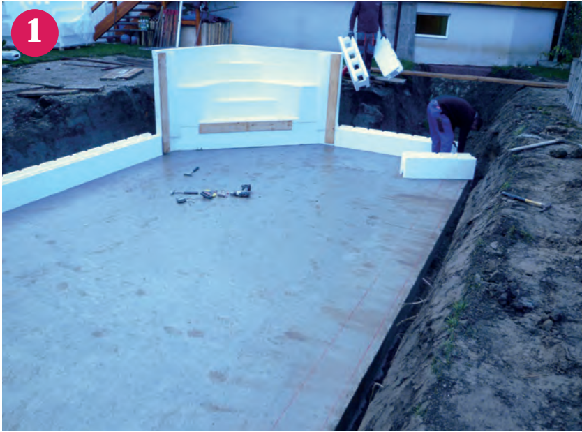
▲ Ecktreppe mit erster Ansatzreihe Styroporsteine
