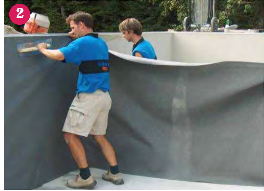
▲ Punktuelle Befestigung der Vliestrennlage mittels Styroporkleber
