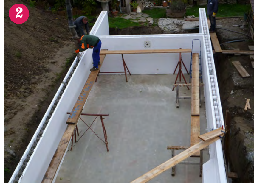
▲ Ausfüllen der Styroporstein mit dem Beton
